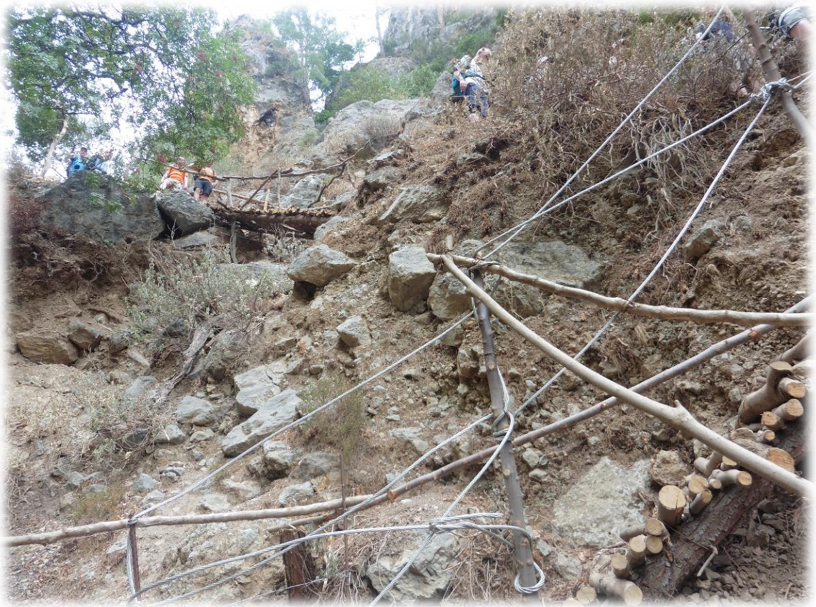
De gehele constructie wordt bij elkaar gehouden met stalen kabels. Het oogt onveilig maar het is wel degelijk veilig.
